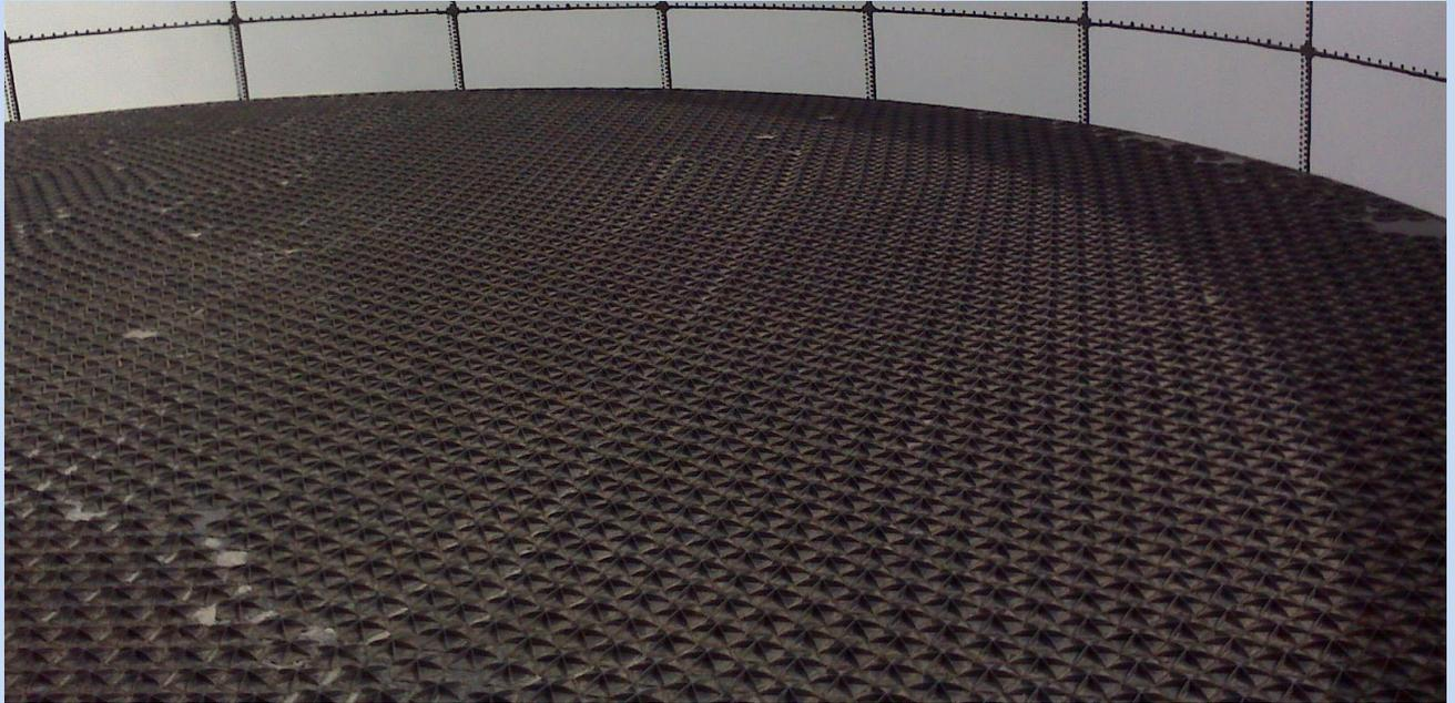
Hexa-Cover der innovative und patentierte Schwimmbelag zur Abdeckung aller Arten von Behältern und Flüssigkeiten. Die ideale Lösung für die Beseitigung von Gerüchen und zur Senkung der
